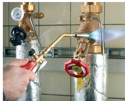
Beflammung zur exakten Probenahme
